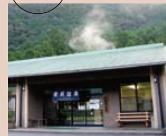
高田グリーンランド雲取温泉 温水ボイラー(10万kcal)5基
