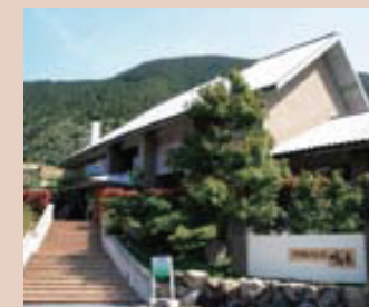
中津温泉あやめの湯鳴滝 温水ボイラー(10万kcal)4基
